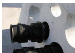
② ハンドホール削穴に受け 継手を挿入
