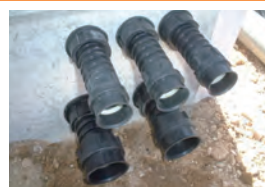
⑤ 受け継手取付完了
