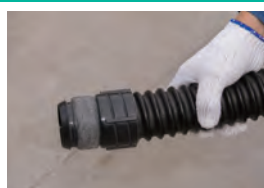
③ 差込継手取付完了
