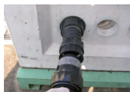
④ ハンドホール側との接続 は差し込むだけです
