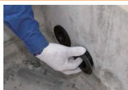
③ ハンドホールの内側から ベルマウスを締め込む
