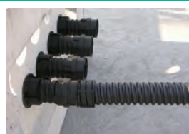
⑤ 管材接続完了
