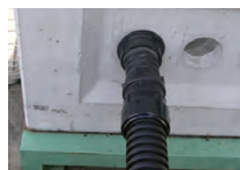
⑤ 管材接続完了
