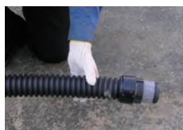
③ 差込継手取付完了
