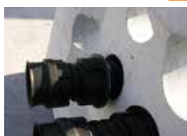
② ハンドホール削穴に受け継手を挿入
