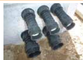
⑤ 受け継手取付完了
