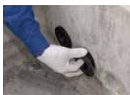
③ ハンドホールの内側からベルマウスを締め込む
