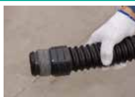
③ 差込継手取付完了
