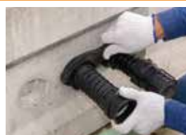
④ ブッシングを締め込む(専用スパナ利用時)
