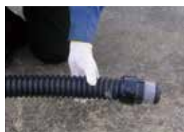
③ 差込継手取付完了
