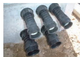
⑤ 受け継手取付完了
