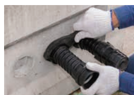
④ ブッシングを締め込む (専用スパナ利用時)
