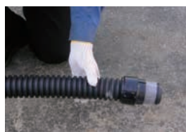
③ 差込継手取付完了
