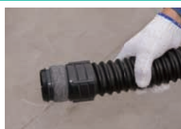
③ 差込継手取付完了
