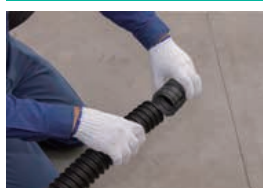
① らせん管に対して差込 継手を差し込みます
