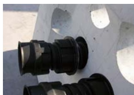
2 ハンドホール削穴に受け 継手を挿入
