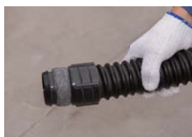
3 差込継手取付完了
