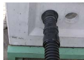
5 管材接続完了
