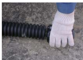
2 独立山管に差込継手を奥 まで差し込みます
