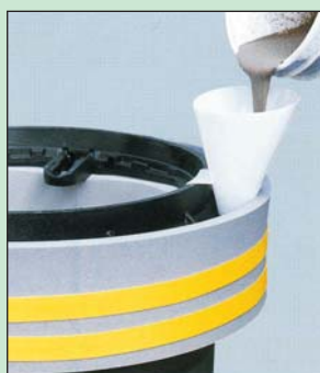
■ハイジャスターを調整部へ流し込む
