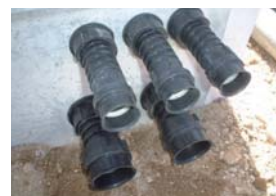
5 受け継手取付完了
