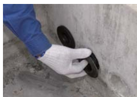
3 ハンドホールの内側から ベルマウスを締め込む
