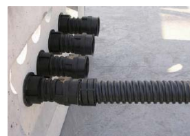
5 管材接続完了
