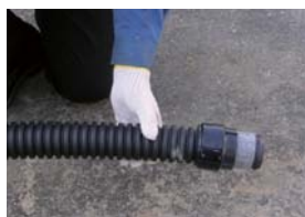
3 差込継手取付完了
