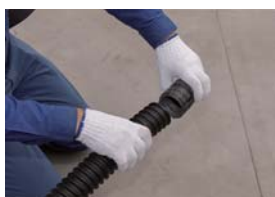
1 らせん管に対して差込 継手を廻し込みます
