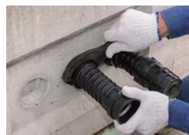
4 ブッシングを締め込む (専用スパナ利用時)
