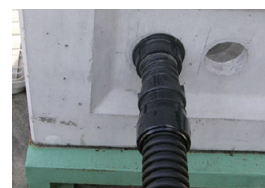
⑤ 管材接続完了
