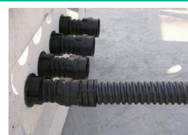
⑤ 管材接続完了
