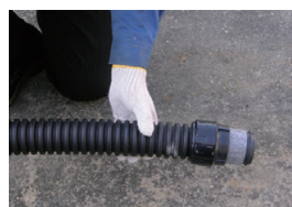
③ 差込継手取付完了
