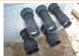
⑤ 受け継手取付完了
