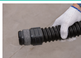
③ 差込継手取付完了
