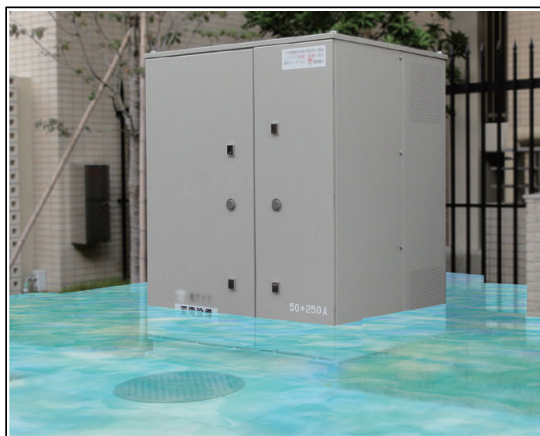
■調整ブロック C100 での施工イメージ 浸水深さ 200mm を超えると盤部分も 水に浸かってしまいます
