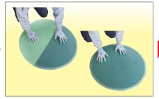
3) 蓋体と養生シートの間にに空気が入ら ないように貼り付けます。
