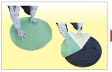
2) 蓋体に養生シートをはみ出さないよう に位置合わせをして被せながら裏紙を 剥します。
